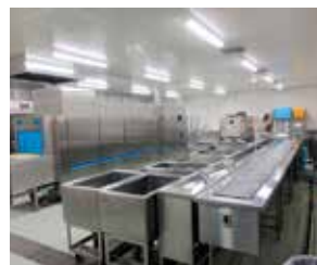
食器洗浄コーナー (食器洗浄機、下膳ベルト)
